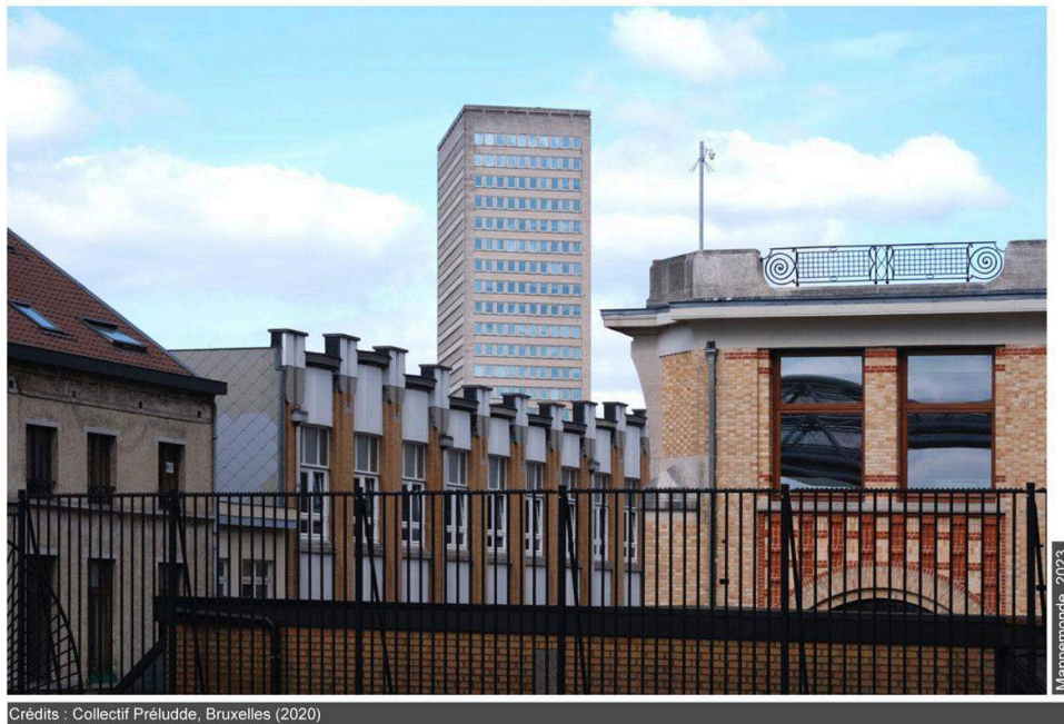
Figure 7. Caméra publique placée au niveau d'un belvédère et protégée par des pics en acier
